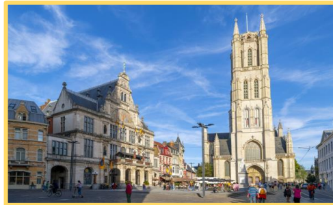
La façade principale de la cathédrale avec, à gauche, un bel alignement de façades
